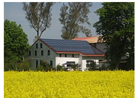
Instalación de energía solar fotovoltaica sobre el tejado de una vivienda rural, en Alemania .
